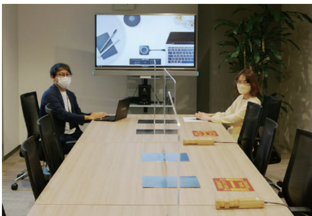
Shure MXA710をモニター下に設置。会議室全体の集音を1台でカバー
